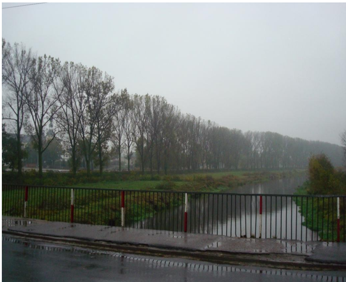
Obszar mostu na Bzurze do modernizacji
