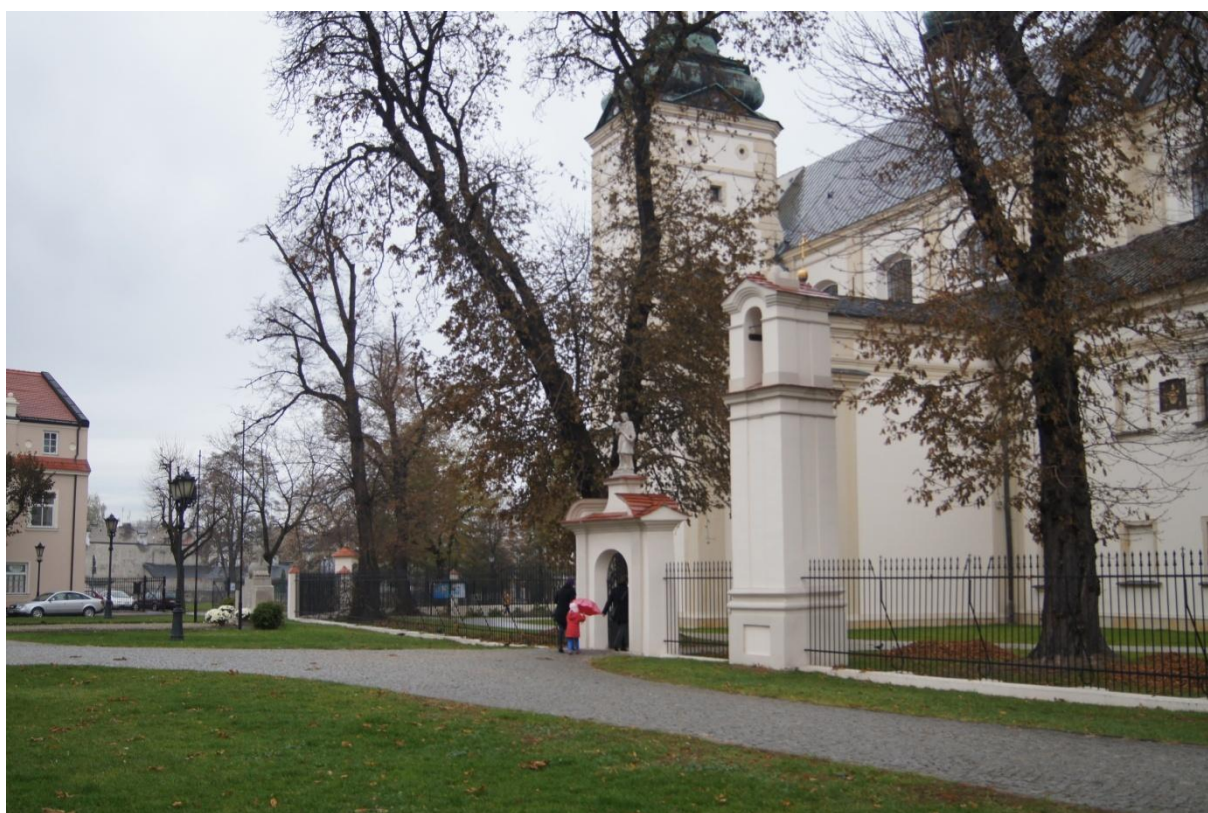
Wyremontowane ogrodzenie otaczające Kolegiatę
