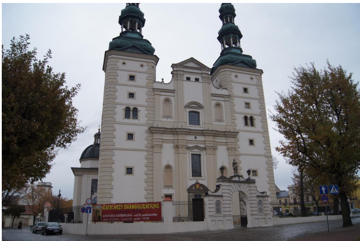
Kolegiata po przeprowadzonym procesie rewaloryzacji
