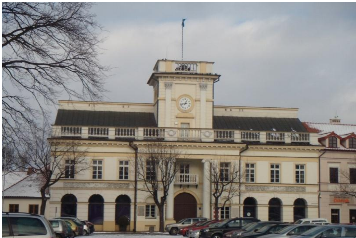
Budynek ratusza wskazany do rewaloryzacji i remontu
