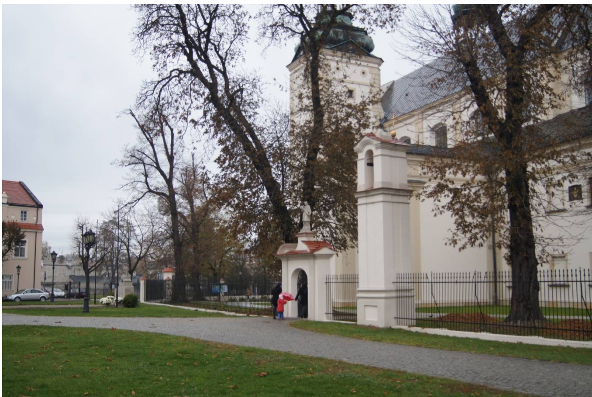
Wyremontowane ogrodzenie otaczające Kolegiatę
