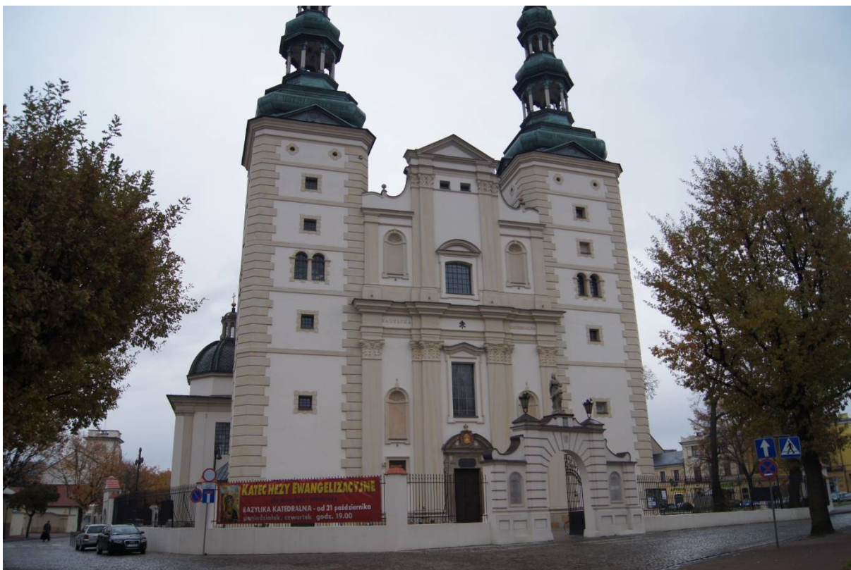
Kolegiata po przeprowadzonym procesie rewaloryzacji
