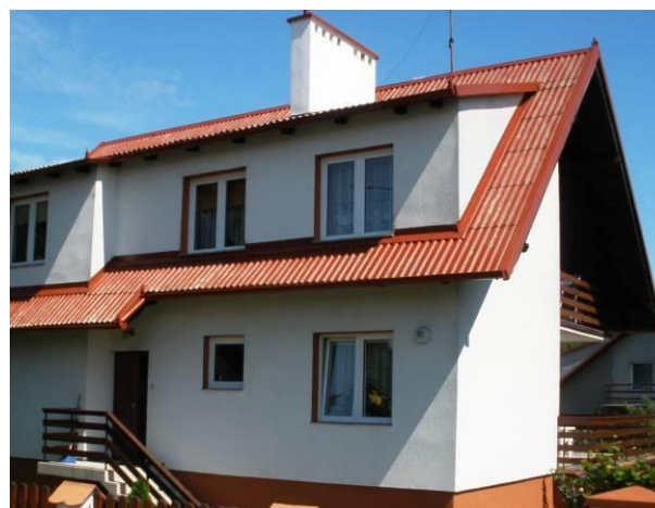
Rys. 5. Przykład zabezpieczenia wykonanego powłoką malarską.
