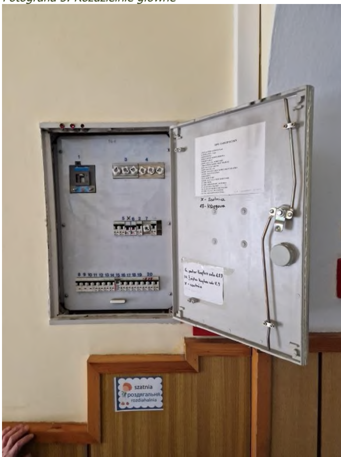
Fotografia 5. Rozdzielnie główne
