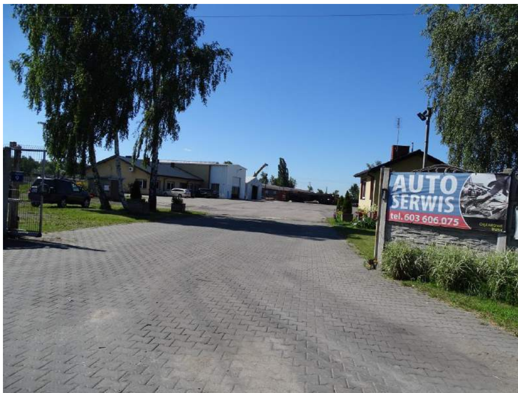
Zdjęcie Nr 44. Zabudowa usługowo-produkcyjna na działce ewidencyjnej Nr 569/1, wgląd z ul. Małszyce w kierunku południowym.
