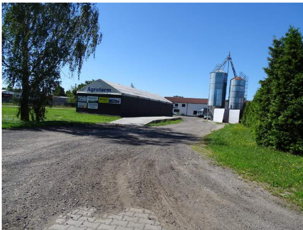
Zdjęcie Nr 45. Zabudowa usługowo-produkcyjna na działce ewidencyjnej Nr 8554, wgląd z ul. Małszyce w kierunku południowym.
