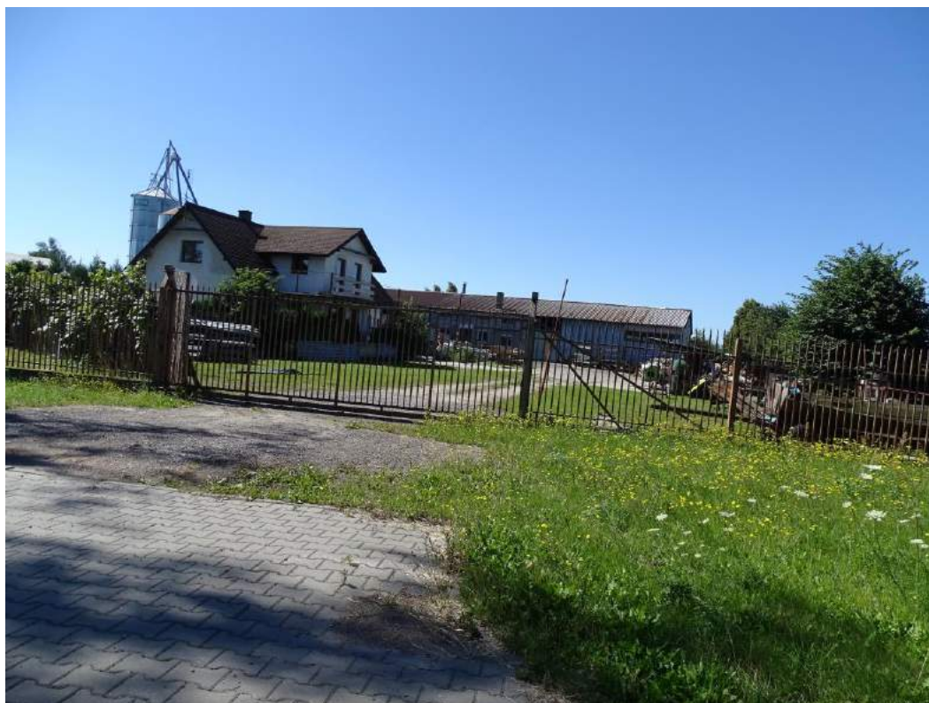
Zdjęcie Nr 46. Zabudowa usługowo-mieszkaniowa na działce ewidencyjnej Nr 8553, wgląd z ul. Małszyce w kierunku południowym.
