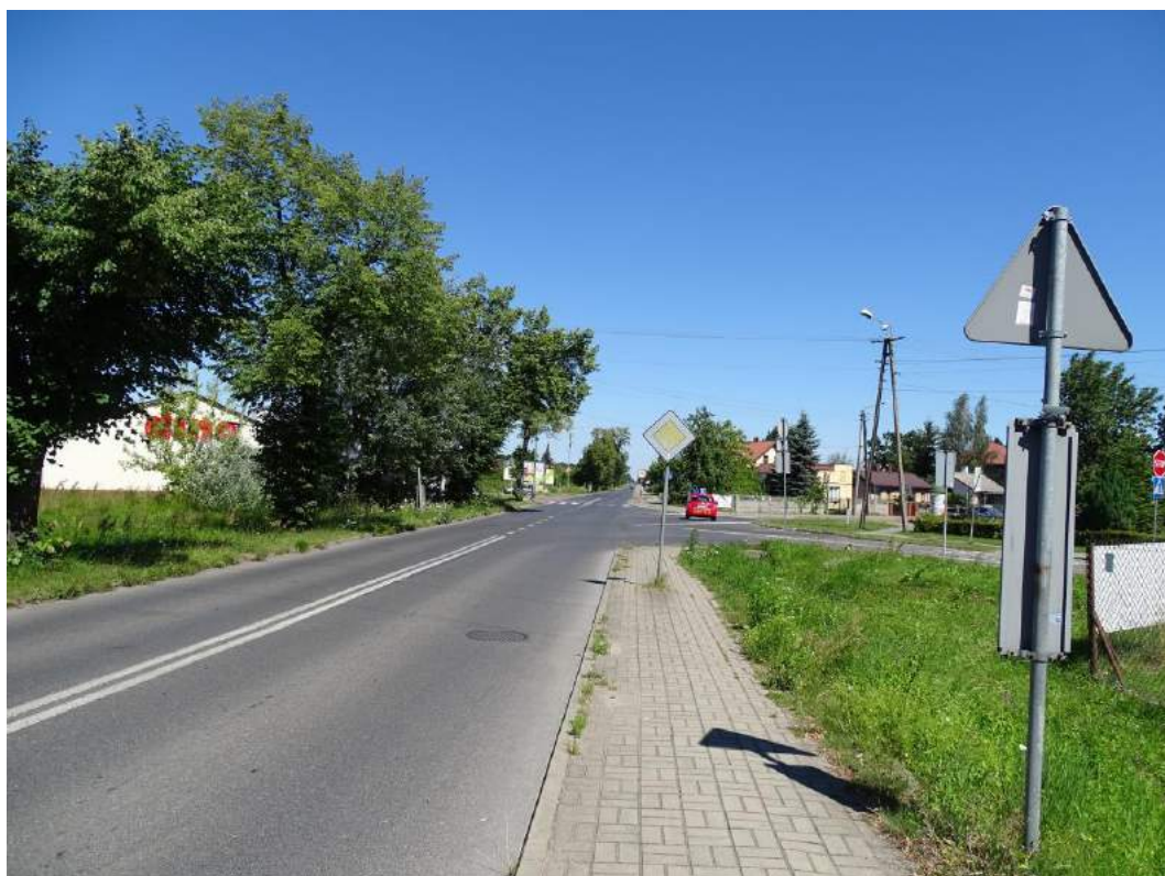
Zdjęcie Nr 19. perspektywa ul. Kiernozkiej od strony przejazdu kolejowego.
