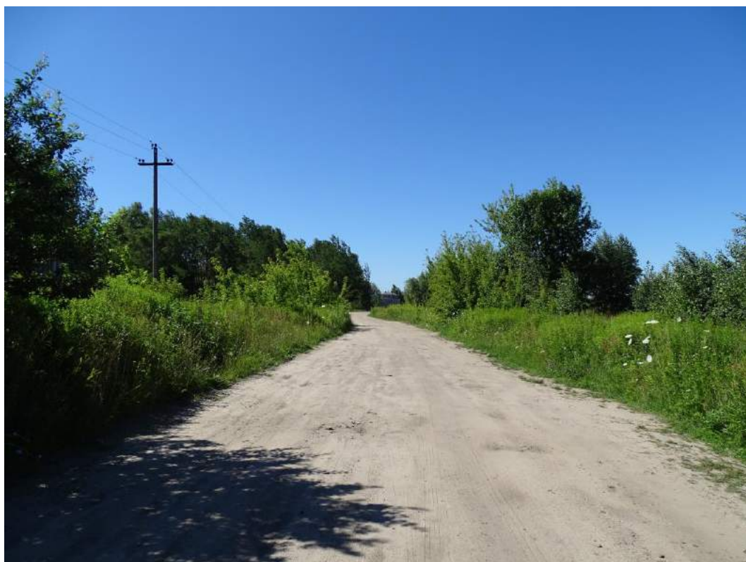
Zdjęcie Nr 39. Ul. Strzelecka, odcinek gruntowy wgląd w kierunku południowym.
