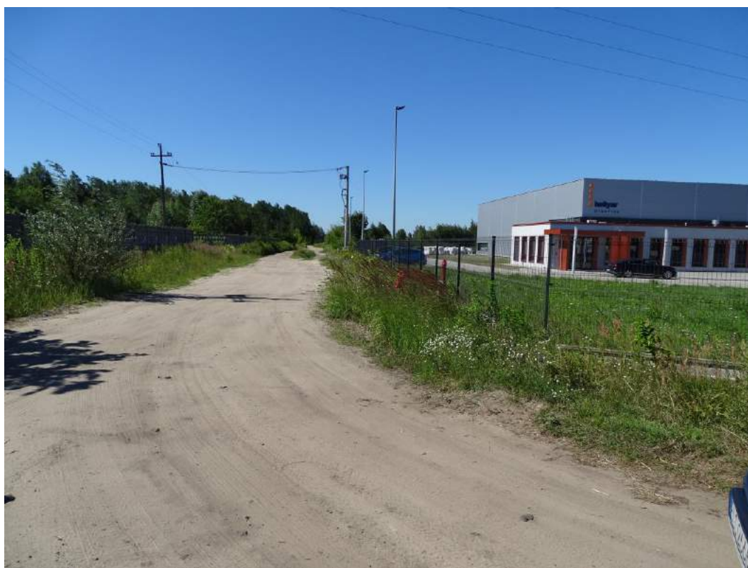
Zdjęcie Nr 41. Perspektywa ul. Strzeleckiej (odcinek gruntowy) z ul. Małszyce w kierunku południowym.
