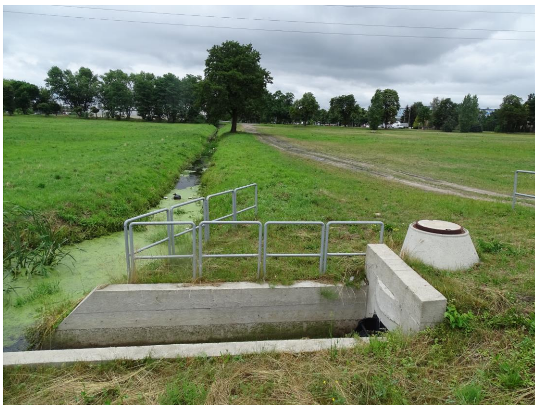
Zdjęcie Nr 37. Wgląd na rów melioracyjny z ul. Romana Dmowskiego w kierunku zachodnim.
