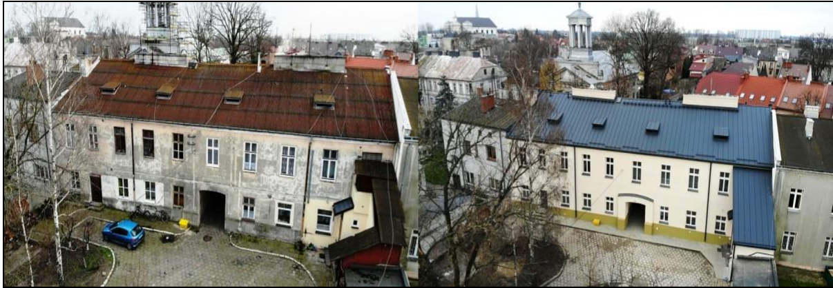
Budynek mieszkalny, wielorodzinny przy ul. Podrzecznej 18 w Łowiczu – tyl (przed i po termomodernizacji)
