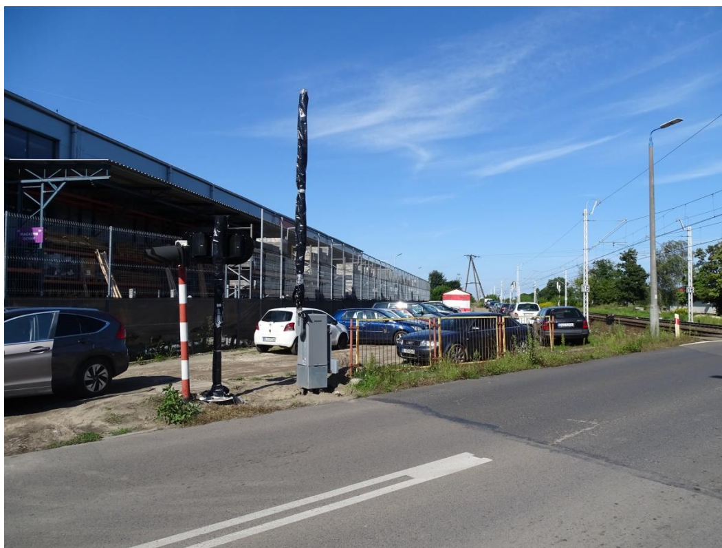
Wgląd na zabudowę produkcyjno-magazynową (działka Nr 1366) z ul. Seminaryjnej w kierunku północno-zachodnim.
