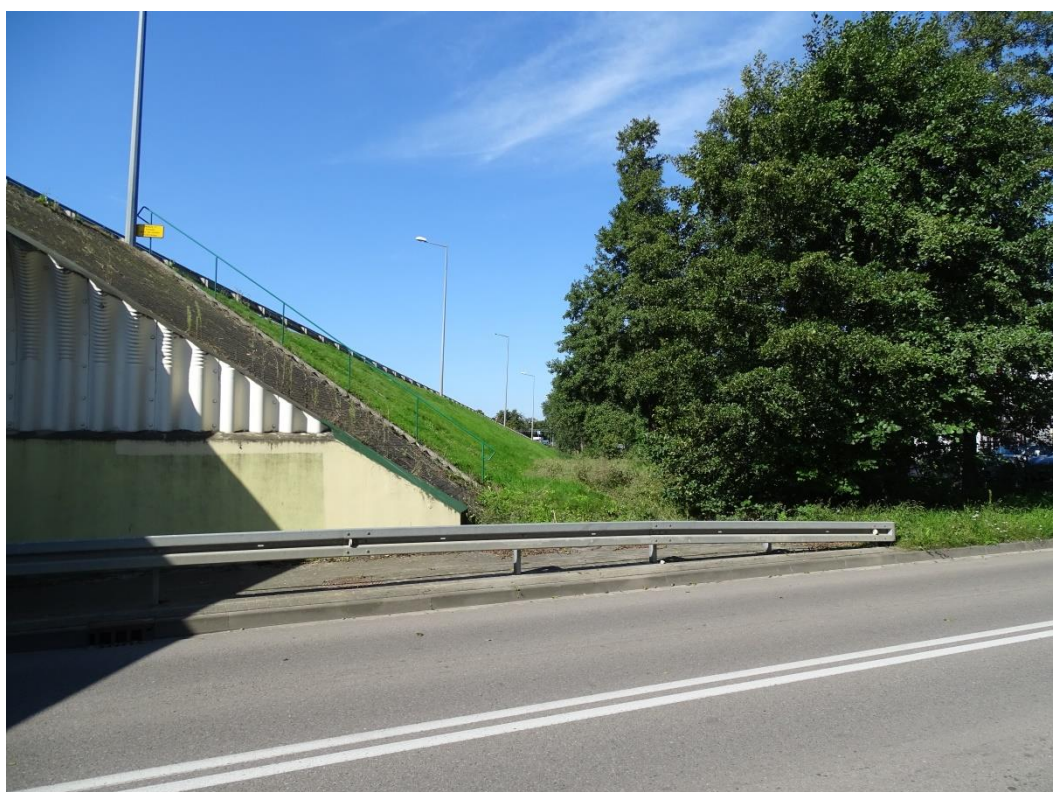
Pas drogowy drogi krajowej Nr 92 z rowem odwadniającym, przy południowej granicy obszaru.
