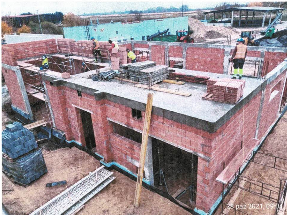
Budynek 19 – strop, ściany, wieńce
