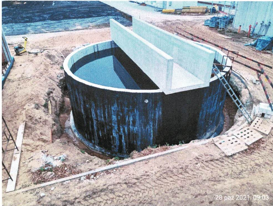
Obiekt 22 Zbiornik osadu przefermentowanego – próba wodna
