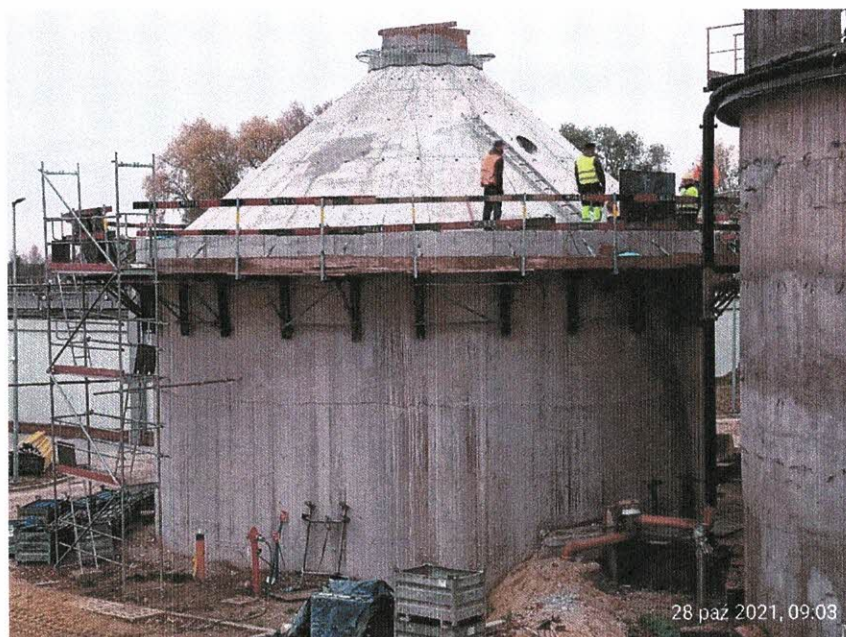
WKF 21.2 – zabetonowana kopuła, zbrojenie ścianek
