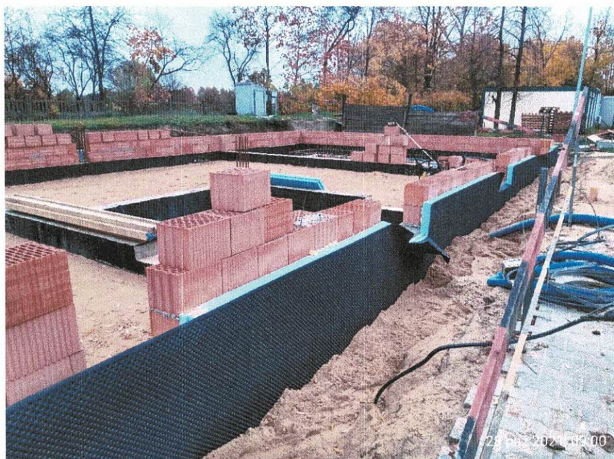
Obiekt 36 budynek warsztatowy, izolacje
