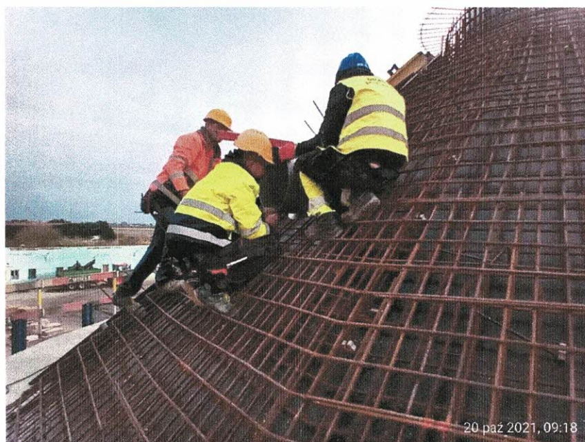
WKF 21.2 – zbrojenie kopuły
