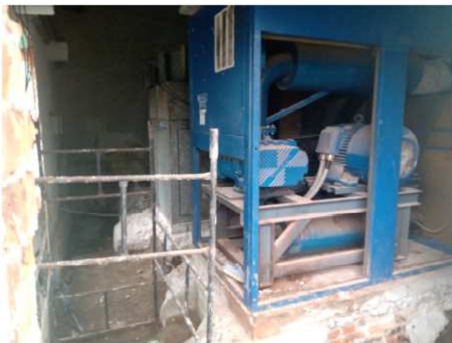
Ob. 13 Stacja dmuchaw, otwory montażowe, budowa kanału
