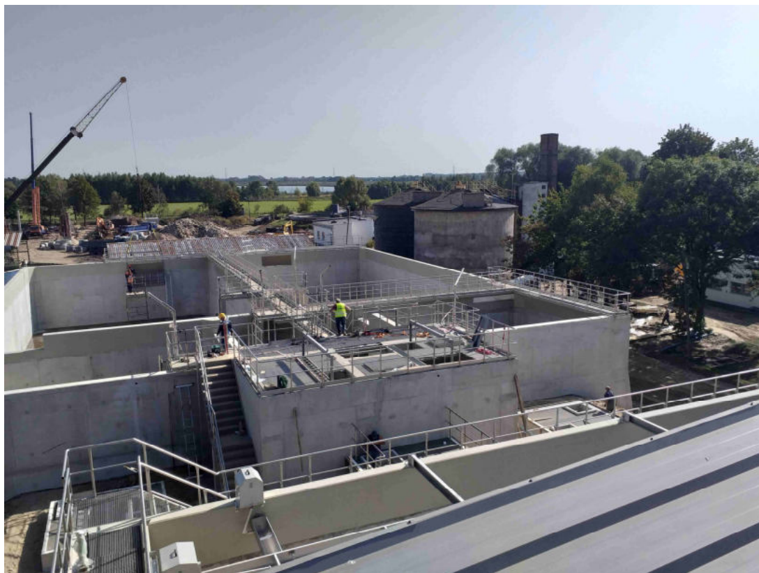
Ob. 5.1-5.2 Komory predenitryfikacji, defosfatacji i denitryfikacji
