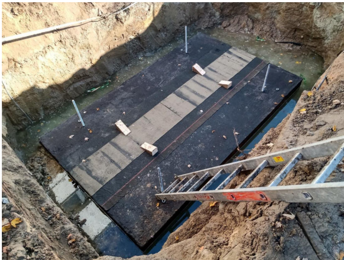
Fundament pod zbiornik oleju
