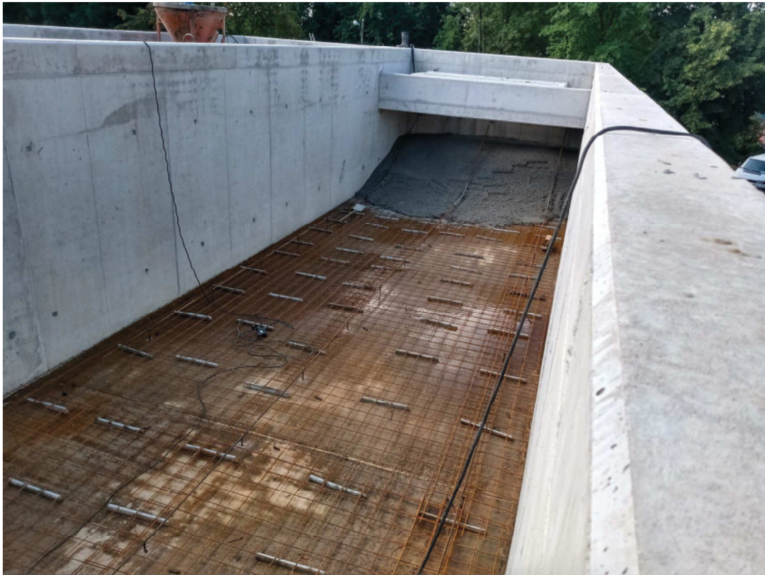
4.1, 4.2 Osadniki – betonowanie skosów
