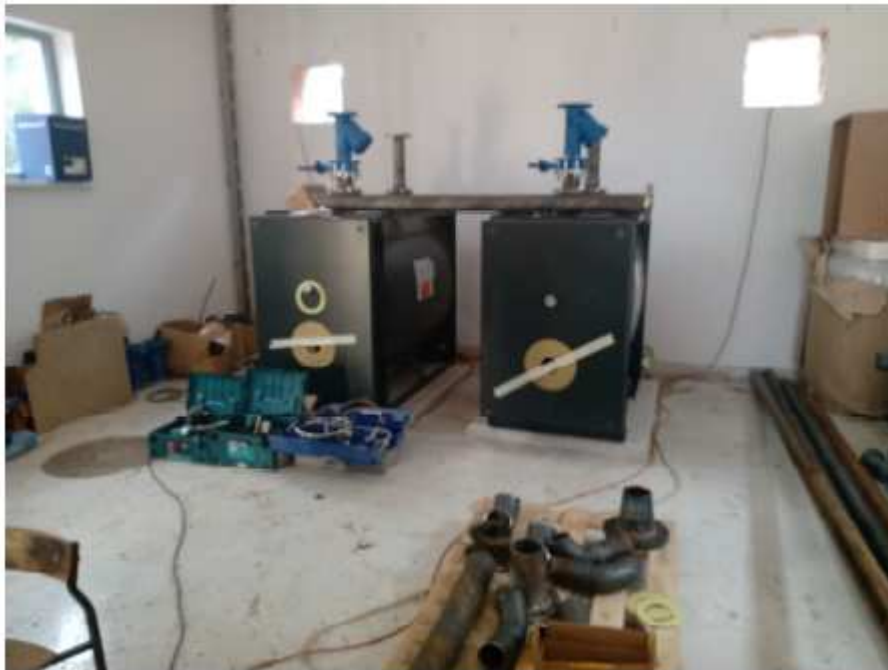
Montaż kotłów c.o.
