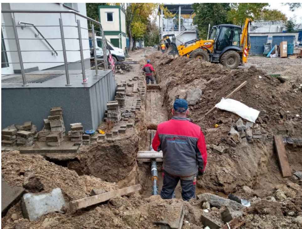
Budowa sieci c.o. – rurociągi preizolowane
