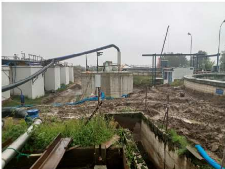
Ob. 7 rurociągi tymczasowe
