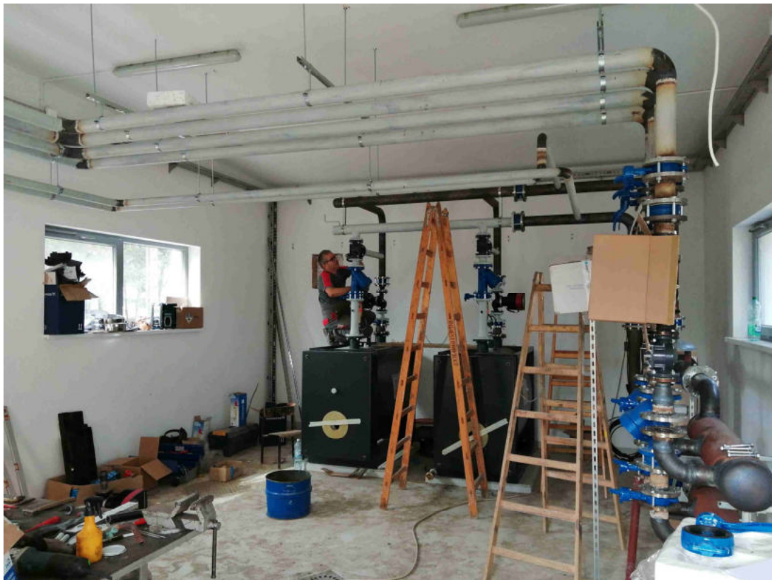
Montaż kotłów i inst. c.o.
