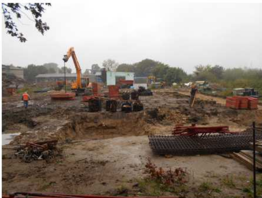
Wiata technologiczna obiekt 42 - roboty fundamentowe
