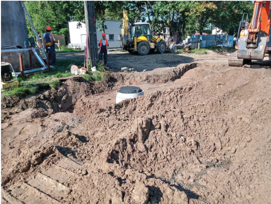
Kanalizacja sanitarna
