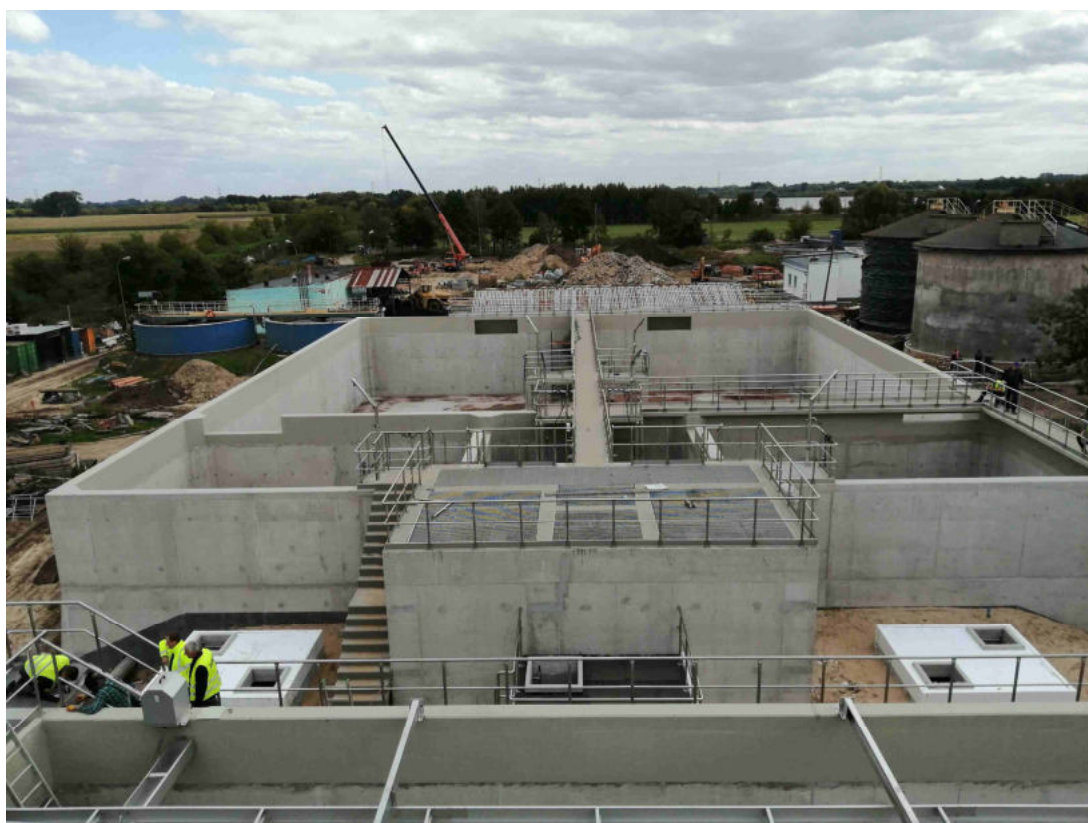
Ob. 5.1-5.2 Komory predenitryfikacji, defosfatacji i denitryfikacji
