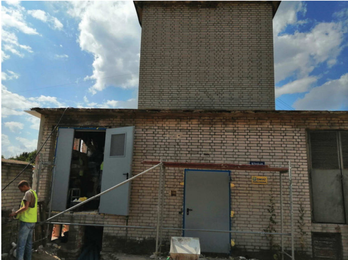
Remont stacji trafo
