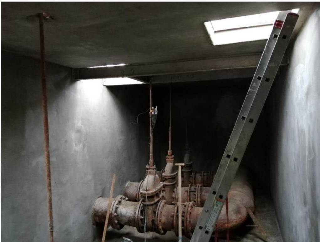
Remont pomieszczeń w pompowni nr 9
